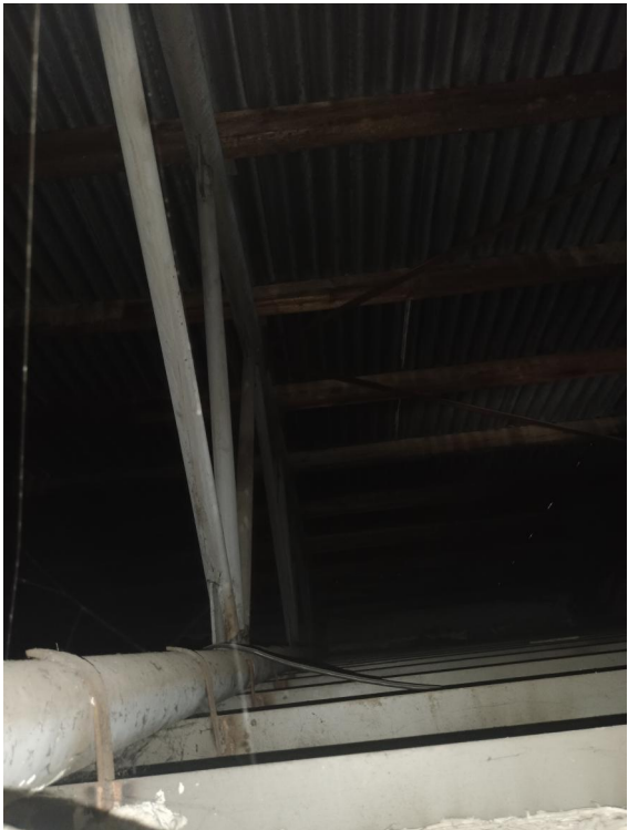
KOTVENÍ ATYPICKÝCH "STROPNÍCH NOSNÍKŮ" NA SPODNÍ PÁSNICI OCELOVÉHO VAZNIKU
