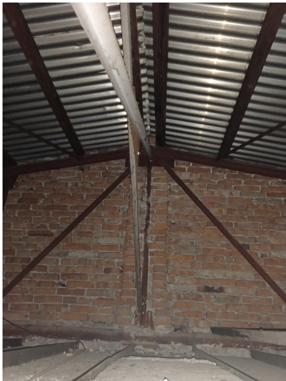
OCELOVÝ PŘÍHRADOVÝ VAZNIK VČETNĚ ZTUŽENÍ
