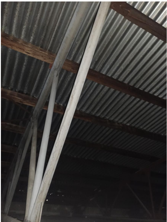
OSAZENÍ DŘEVĚNÝCH VAZNIKŮ NA HORNÍ PÁSNICI OCELOVÉHO VAZNIKU POMOCÍ L ÚHELNÍKŮ
