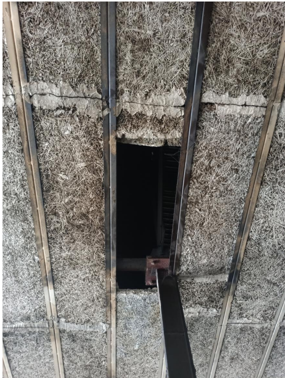
STŘEDOVÝ OCELOVÝ SLOUP PODPÍRAJÍCÍ OCELOVÝ PŘÍHRADOVÝ VAZNIK
